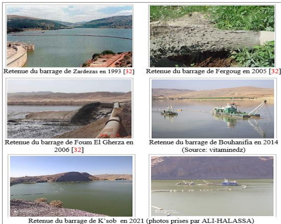
Figure 2.5. Opération de dragage des retenues de barrages Algériens
