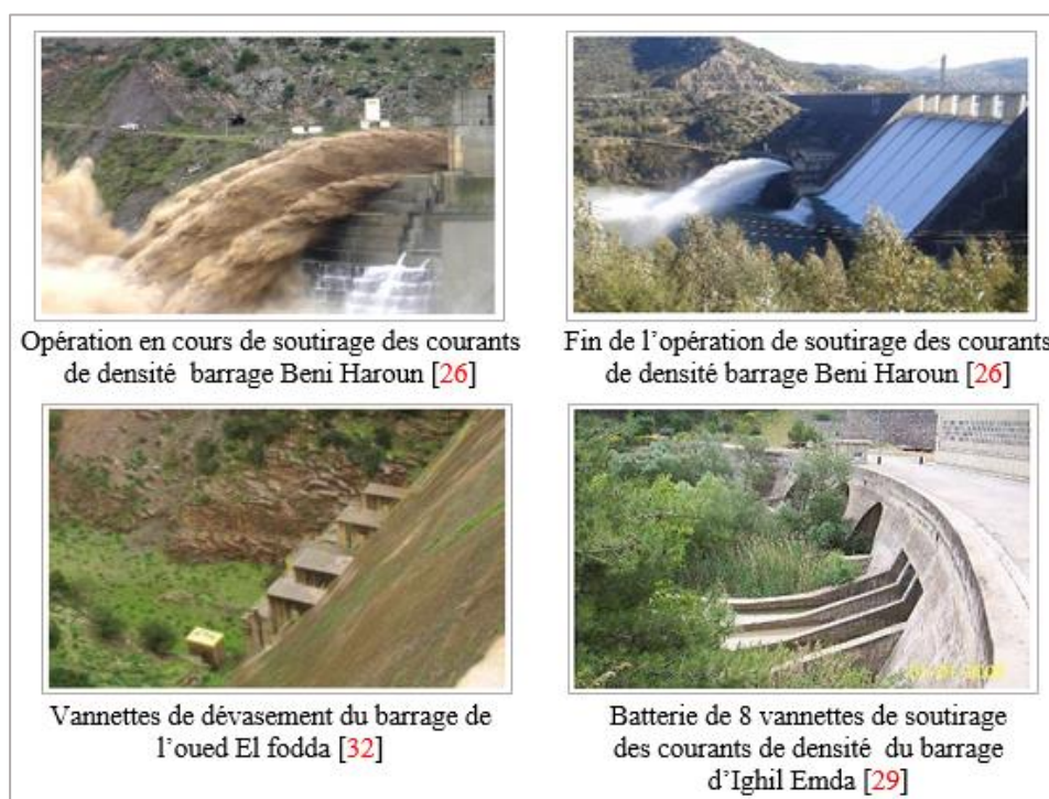
Figure 2.7. Soutirage des courants de densité des barrages Algériens
