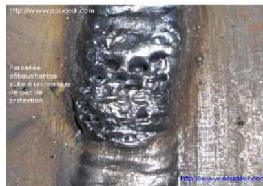
Fig.II.3. Porosités débouchâtes en surface du cordon de soudure.
