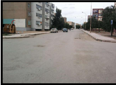
الصورة رقم 27 حالة الطرقات المصدر : تصوير الطالب
