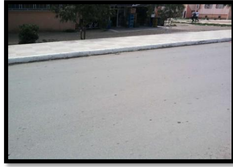
الصورة رقم 24 حالة الطرقات المصدر : تصوير الطالب
