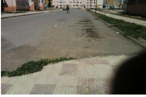
الصورة رقم 23 بنية الطرق بالحي المصدر : تصوير الطالب
