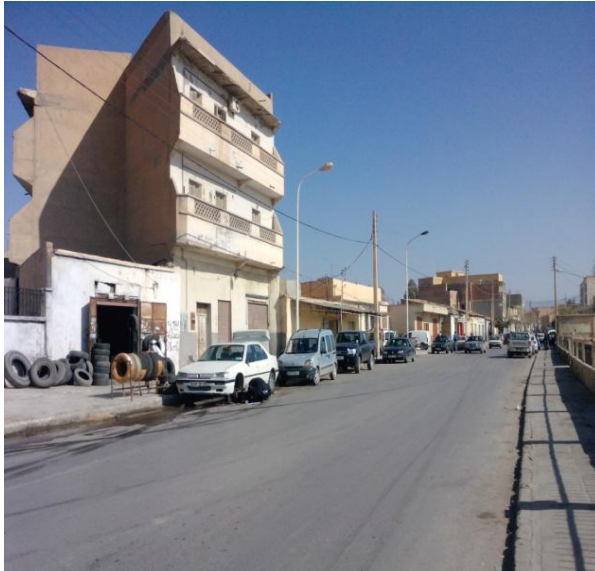
الصورة رقم 08 طرق غير مهيأة (طريق بوسعادة) المصدر : تصوير الطالب
