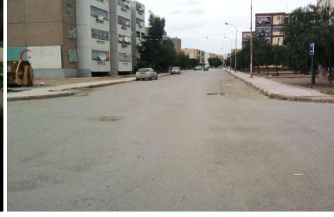
الصورة رقم 22 بنية الطرق بالحي المصدر : تصوير الطالب
