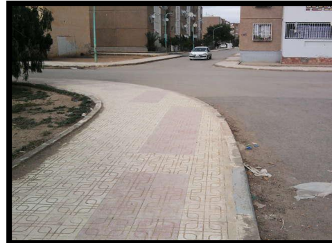
الصورة رقم 26 حالة الطرقات المصدر : تصوير الطالب
