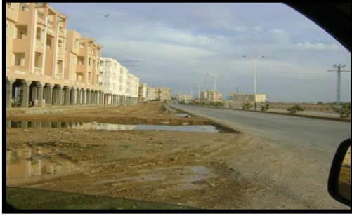
الصورة رقم 10 حالة الطرق بالمدينة المصدر : تصوير الطالب
