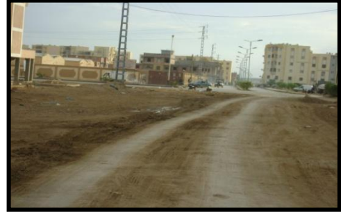
الصورة رقم 09 حالة الطرق بالمدينة المصدر : تصوير الطالب
