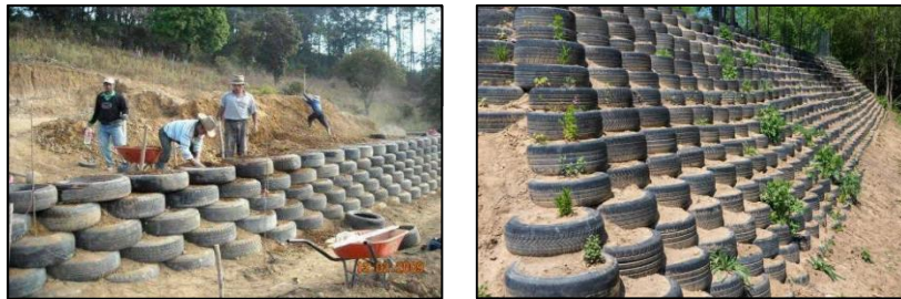
Figure 1.18 Parement en Pneus sol
