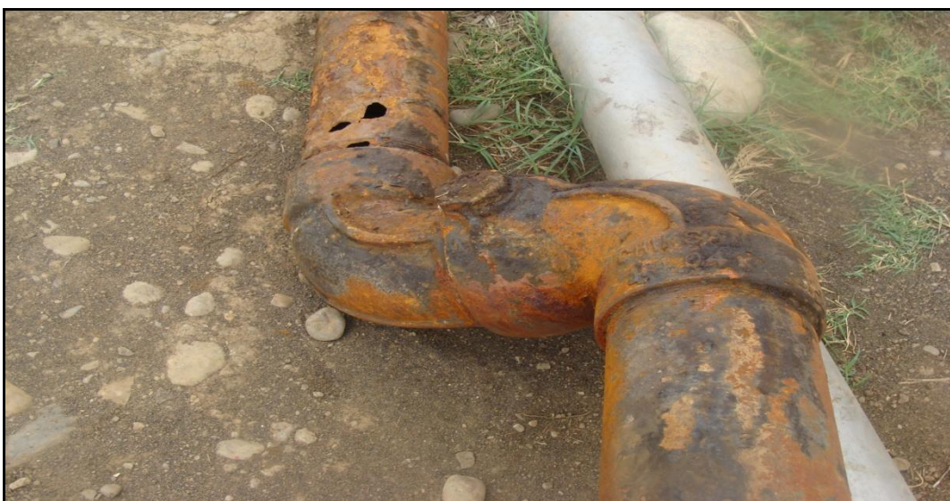
Figure I-1 : conduite affectée par la corrosion à l'extérieur.
