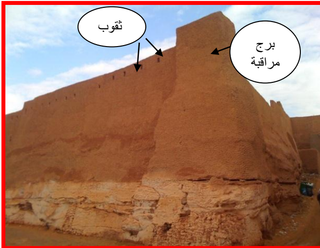
الصورة رقم (2): صورة للسور الخارجي المثقب
