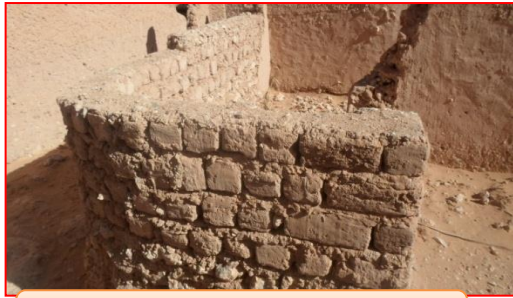
الصورة رقم (13) : الجدار
