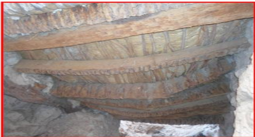
الصورة رقم (11) : تركيب السقف
