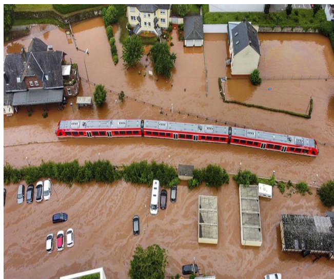
Figure n°6 : Kordel, Allemagne le 15 juillet 2021, inondée par la rivière Kyll. (Sébastien Schmitt/AP/SIPA)
