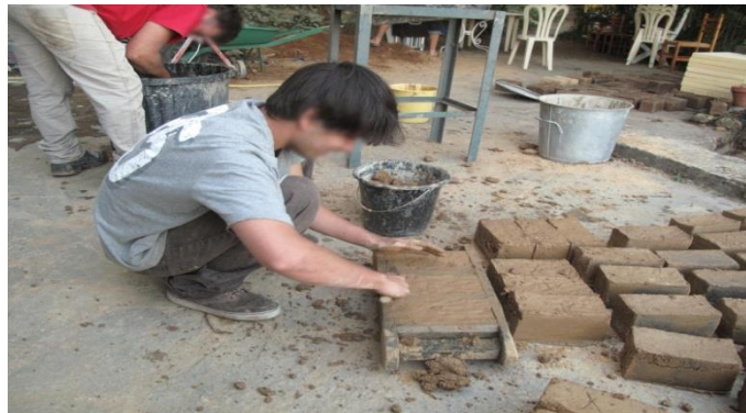
Figure. I.3. exemple de fabrication d'Adobe.
