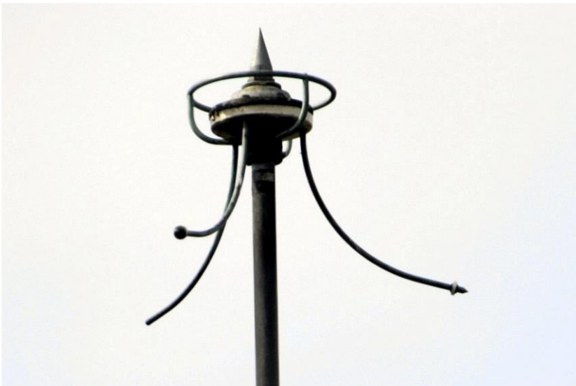
Figure III-12 :Paratonnerre radioactif
