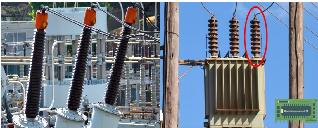
Figure II-16 : Les traversées de transformateur
