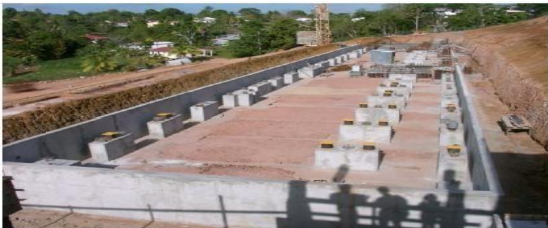
Figure 2 : Mise en place des isolateurs sur les massifs d'une structure.
