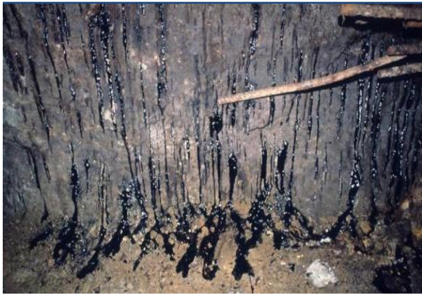
Photographie 1. Straterenfermant hydrocarbures (pétrole)
