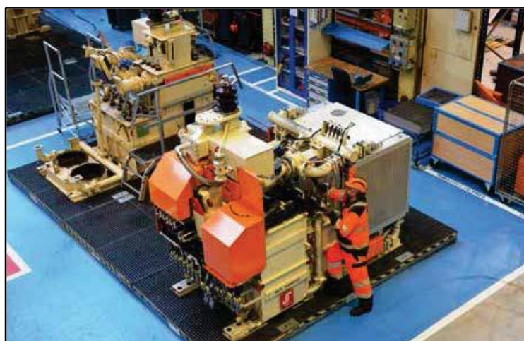
Figure (I-15) : Transformateur de TGV – Photo : SNCF
