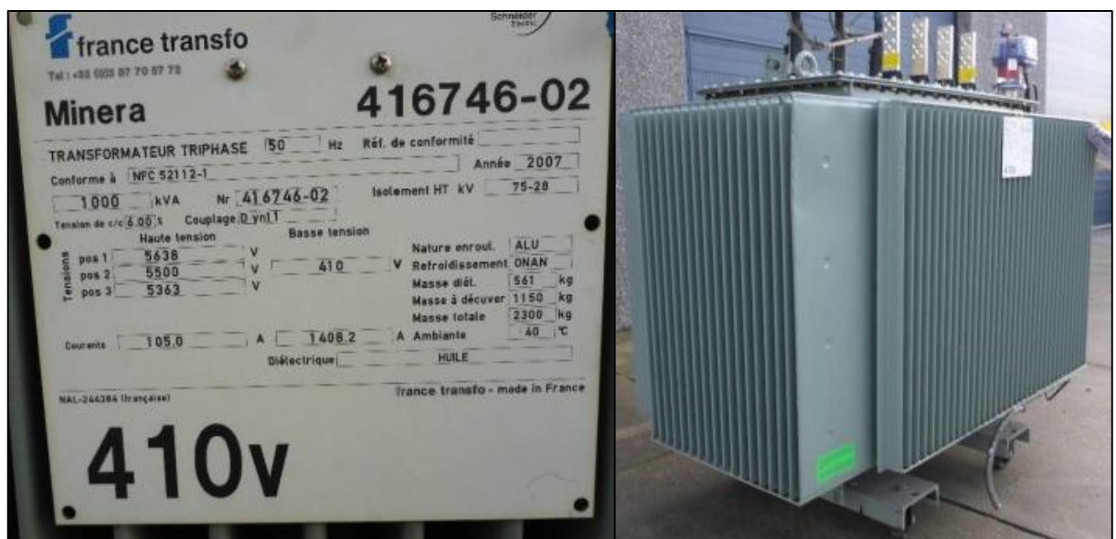
Figure (I-31) : La plaque signalétique d'un transformateur
