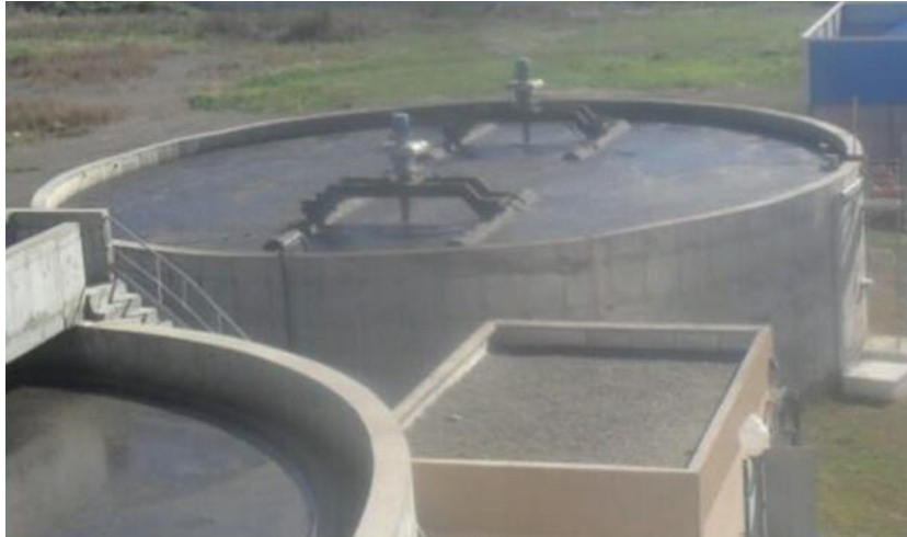
Figure I.4. Bassin de stabilisation de la station d'épuration.
