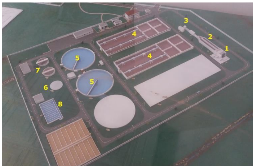
Figure II.3. Les processus d'épuration des eaux usées urbaines dans la STEP de M'sila.
