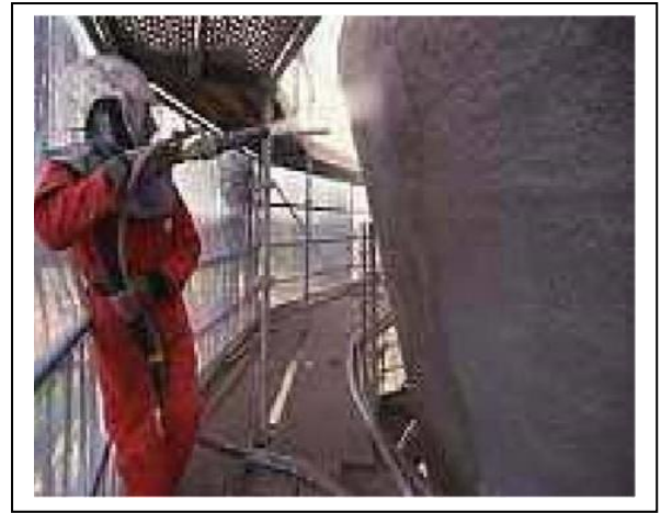
Figure III.3 : Renforcement au moyen de béton projeté
