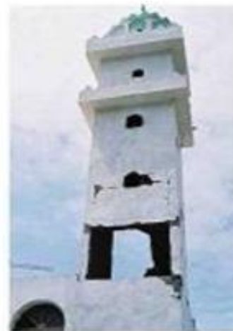
Figure II.9 : changement brusque des rigidités en élévation
