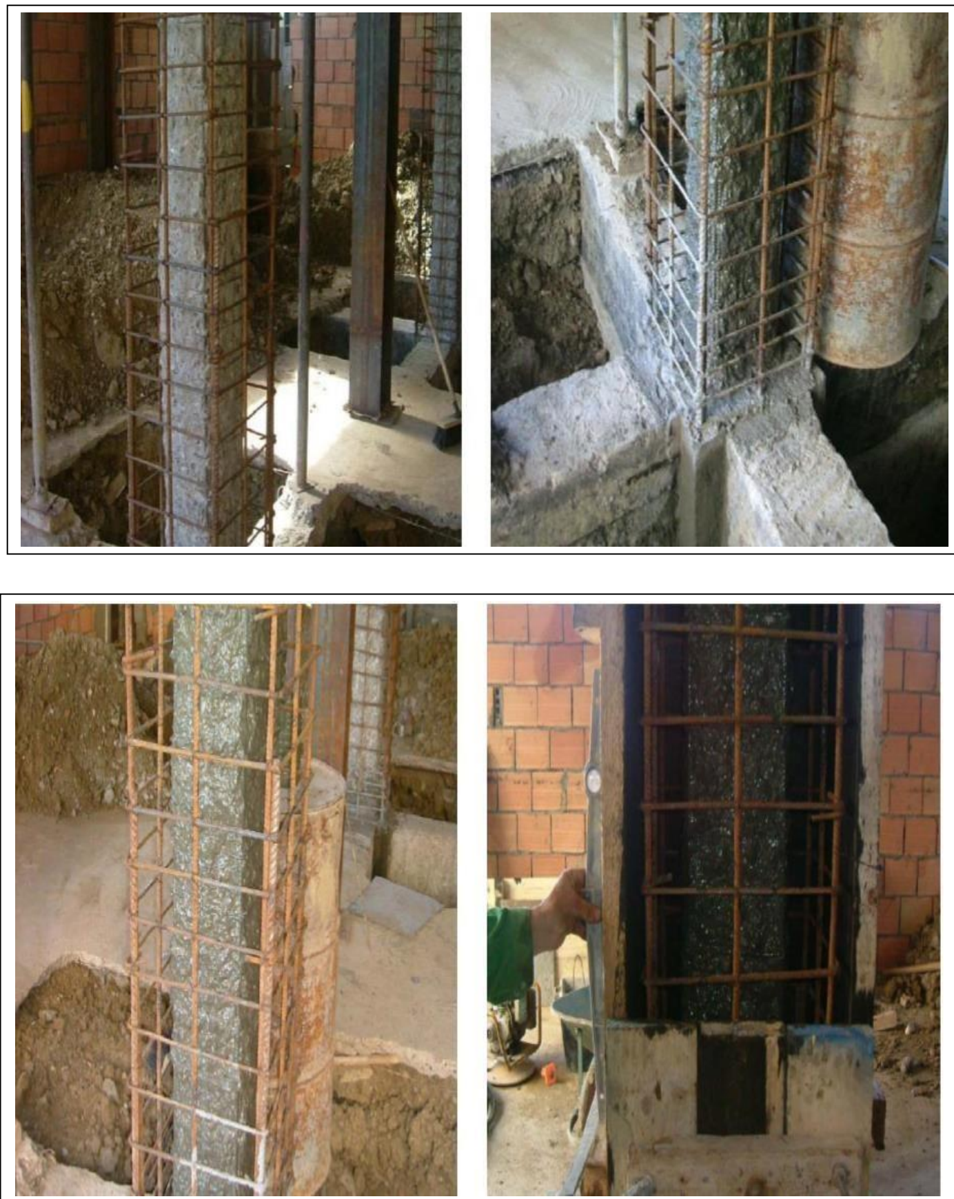
Figure III.12 : Coffrage à mi-hauteur et résultat après décoffrage
