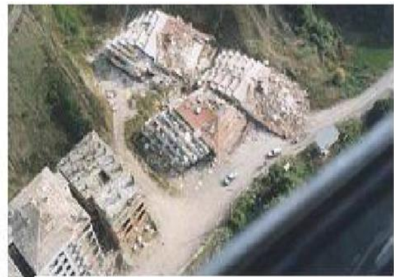
Figure II.7 : effondrement par manque de ductilité
