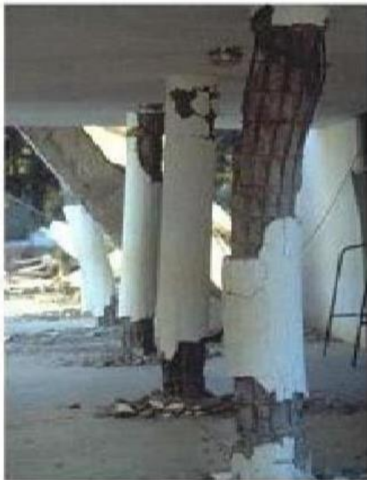
Figure II.4 : poteaux de géométrie élancée a subi une flexion globale
