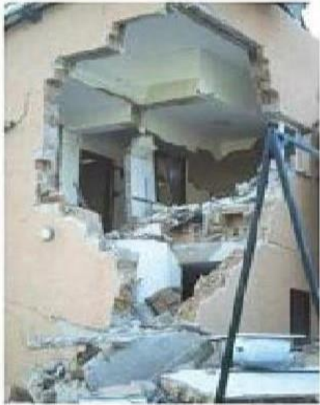
Figure II.2 : maçonnerie non chaînée
