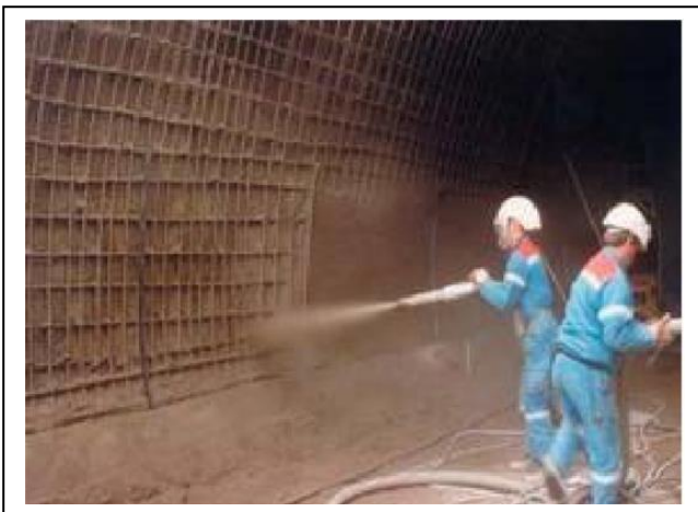
Figure III.3 : Renforcement au moyen de béton projeté
