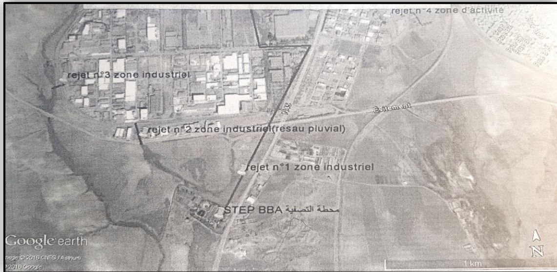
Les déferons rejets de la zone industrielle BBA
