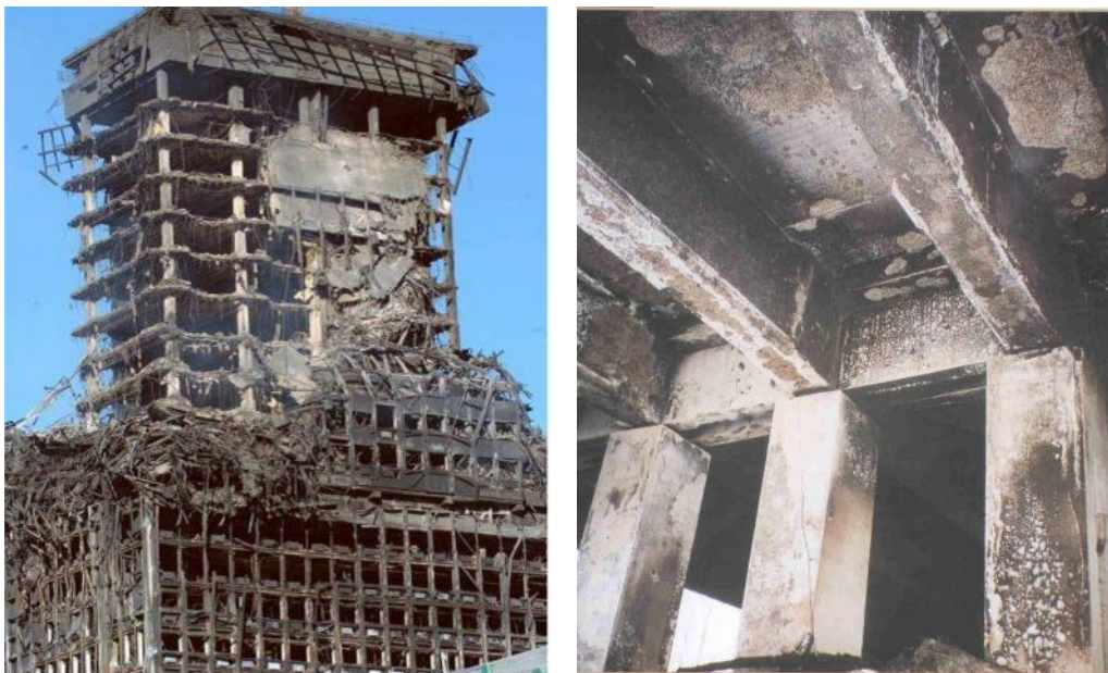
Figure I.7. À gauche, photo du bâtiment Windsor à Madrid après l'incendie.
