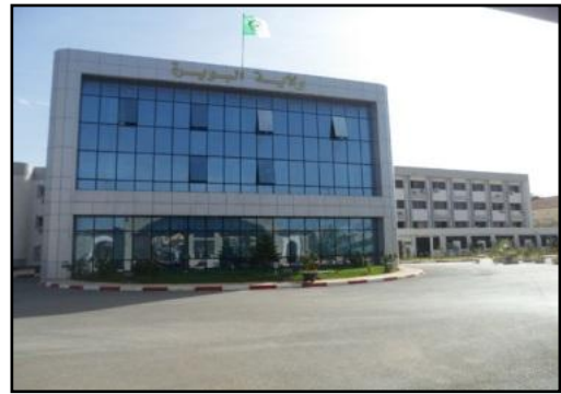
Photo n°29 : Siège de la Wilaya.
