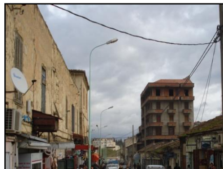
Photo n°47 : Le cadre bâti.
