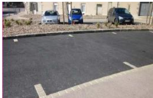
Photo n°11 : Stationnement en pavés résine.
