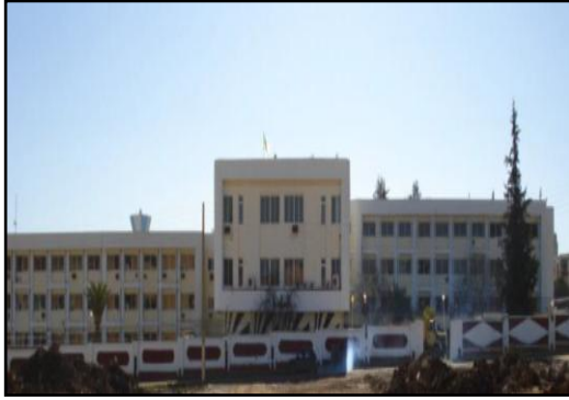
Photo n°19 : Siège de la Wilaya.
