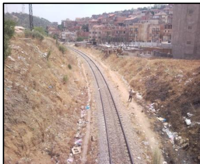
Photo n°26 : La voie ferrée.
