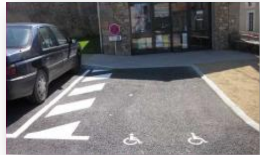
Photo n°06 : Marquage en peinture.
