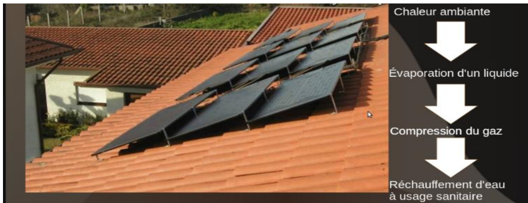
Figure I. 8 : Principe de fonctionnement de panneaux solaires thermodynamique
