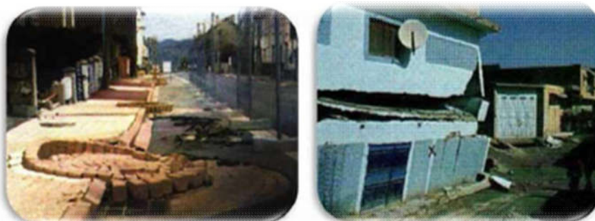
Figure I.2: Effondrement de la ville de Cheria en 2009 et les dommages induits.
