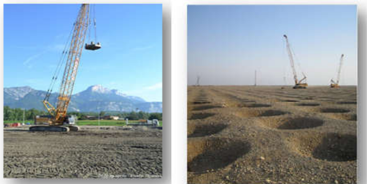
a. Atelier de compactage dynamique
