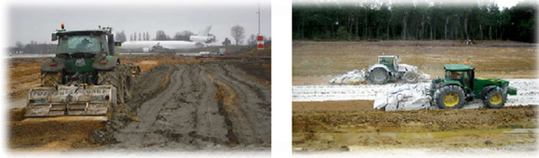
Fig.I.11 : Traitement chimique à la chaux et au ciment.
