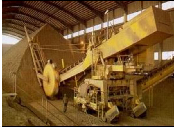
Figure I. 4: Hall de pré-homogénéisation du cru.
