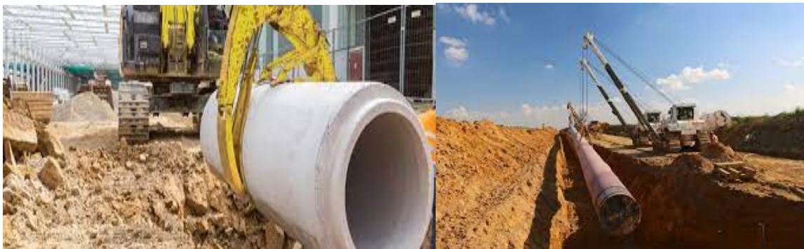
Figure VII.1: Pose de la canalisation.
