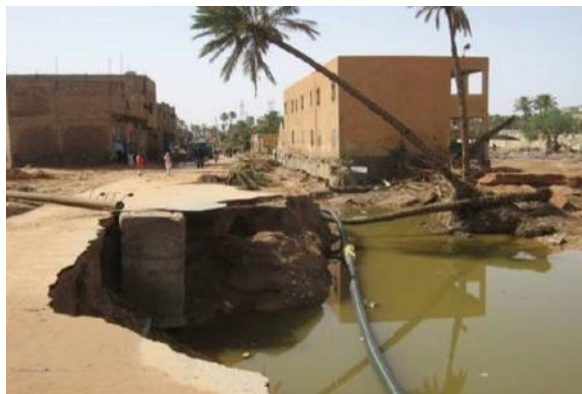
Figure 1.4. Montrant l'ampleur des dégâts de l'inondation du Ghardaïa en octobre 2008 (Source Google)
