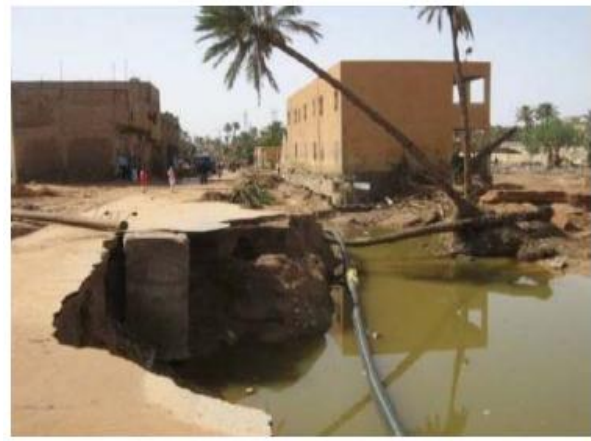
Figure I.14. Montrant l'ampleur des dégâts de l'inondation du Ghardaïa en octobre 2008 (Source Google)
