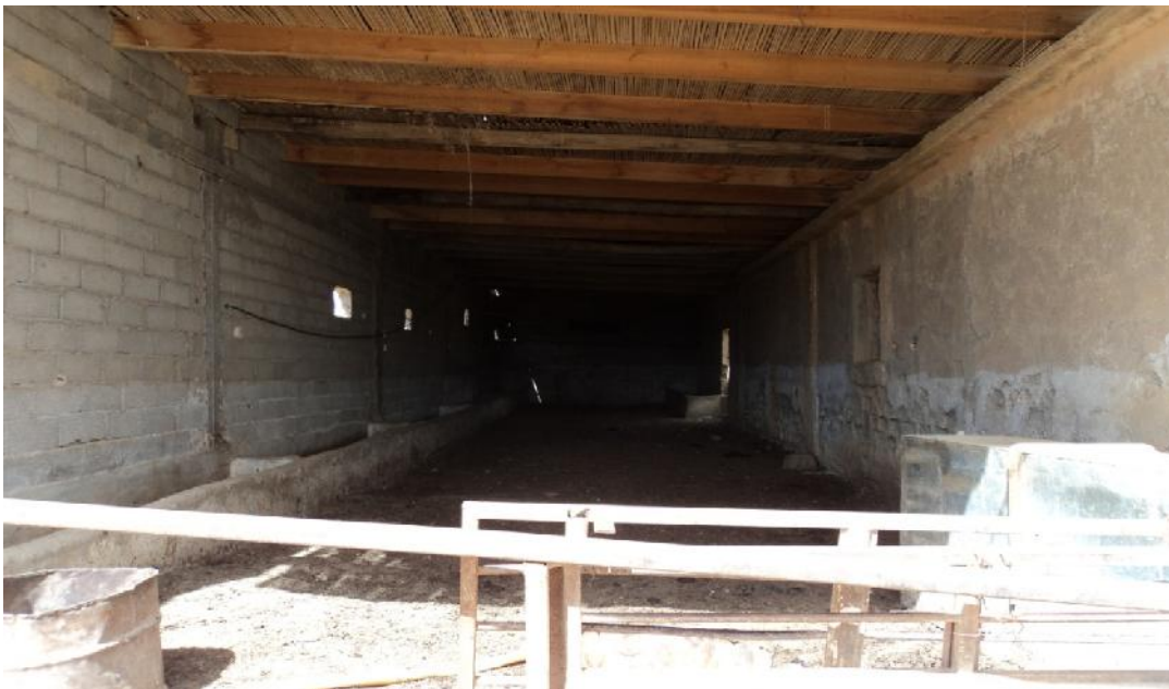
Annexes 11: Bâtiment d'élevage ancien
