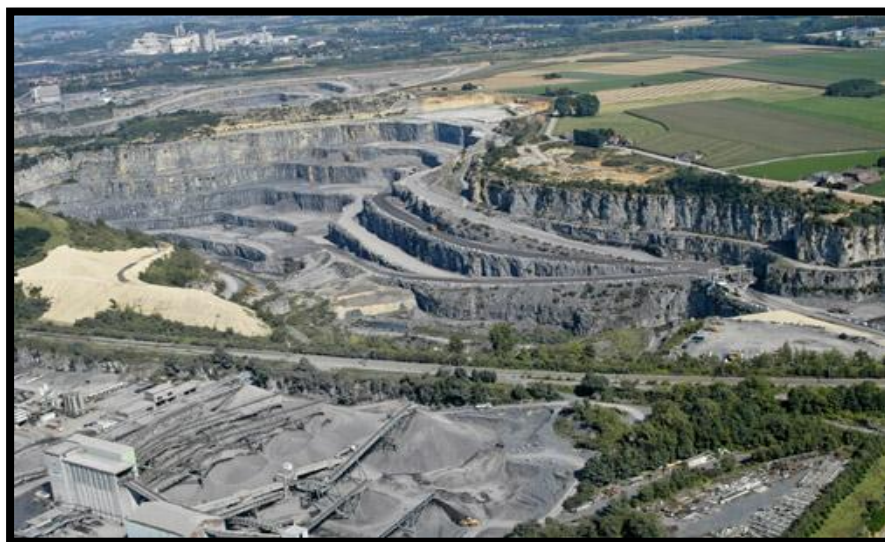
Figure I-6 : Carrière d'extraction d'argile et de calcaire [3]
