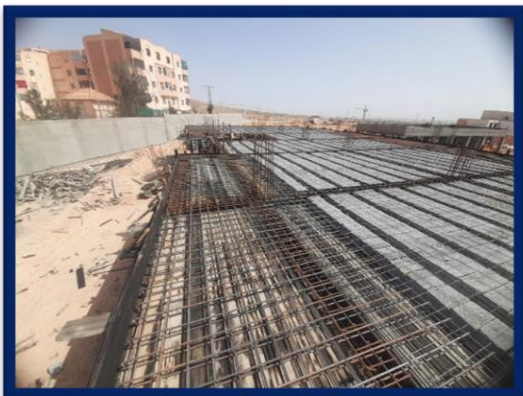
رسم توضيحي 8 بناء سقف السكنات الوظيفية
