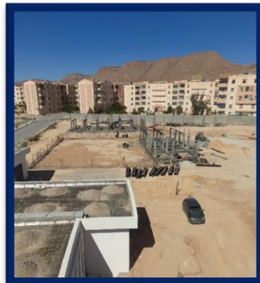
رسم توضيحي 7 تسليح قاعة الرياضة
