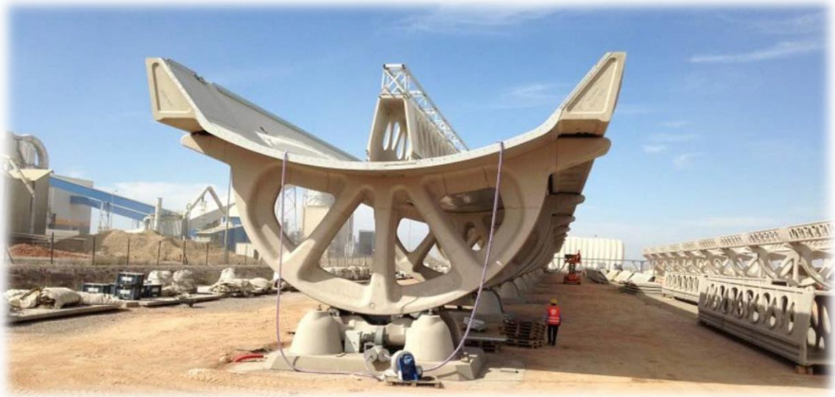
Figure II.23 Photographie du chantier à Aït Baha, Maroc [135].
