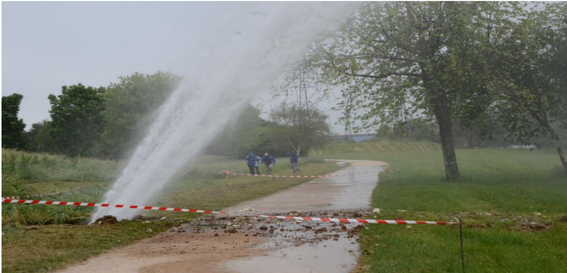
Fig. I. 1 Fuites dans une canalisation sur un réseau d'eau potable.
