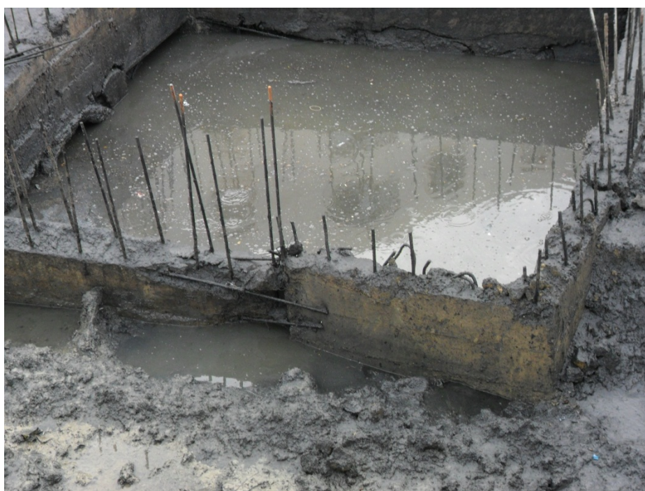
Fig. III 1 : photo du point de rejet (Bassin de décantation)
