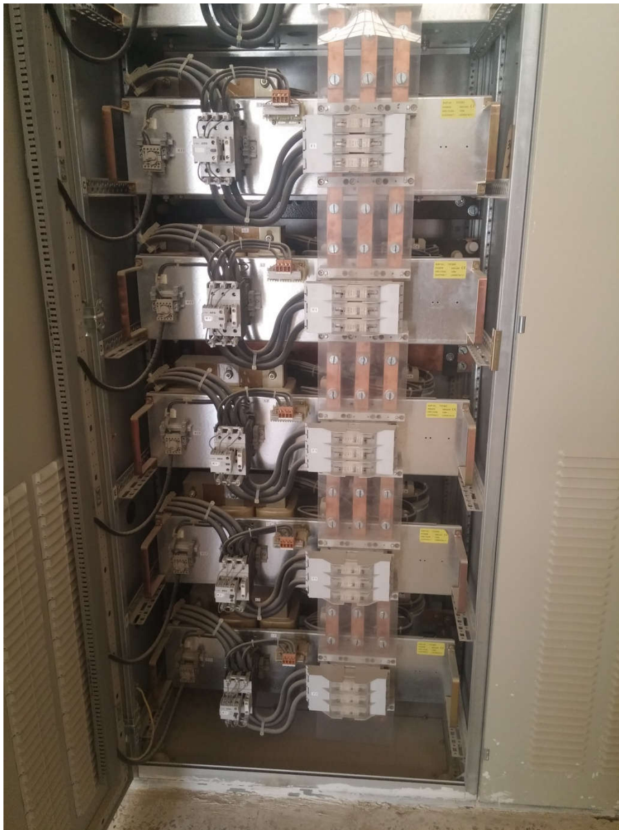
Figure IV.14 Les gradins de compensation
