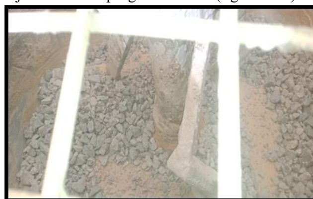
Fig.III. 8 Malaxage du béton ordinaire
