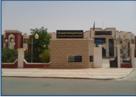
صورة رقم (04): توضح عيادة متعددة الخدمات المصدر: التقاط الطالب 2017
