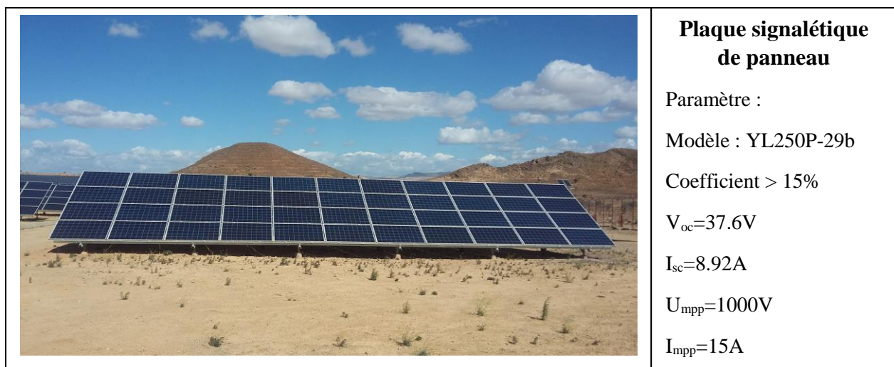
Figure IV.2. Panneaux solaires poly cristallin YGE 60 cellules.
