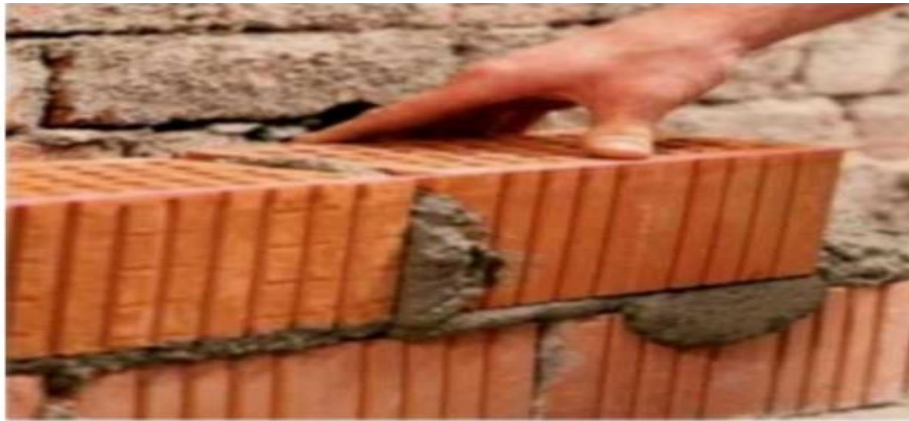
Figure I.3: Les joints de maçonnerie [10]
