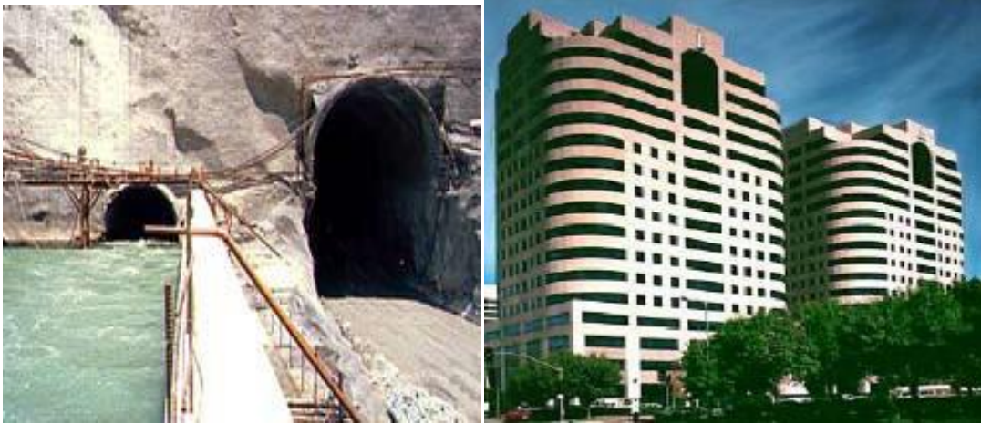
b) Galerie à eau et constructions
