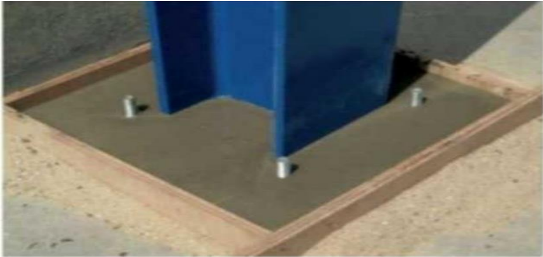
Figure I.4: Les scellements et les calages [10]
