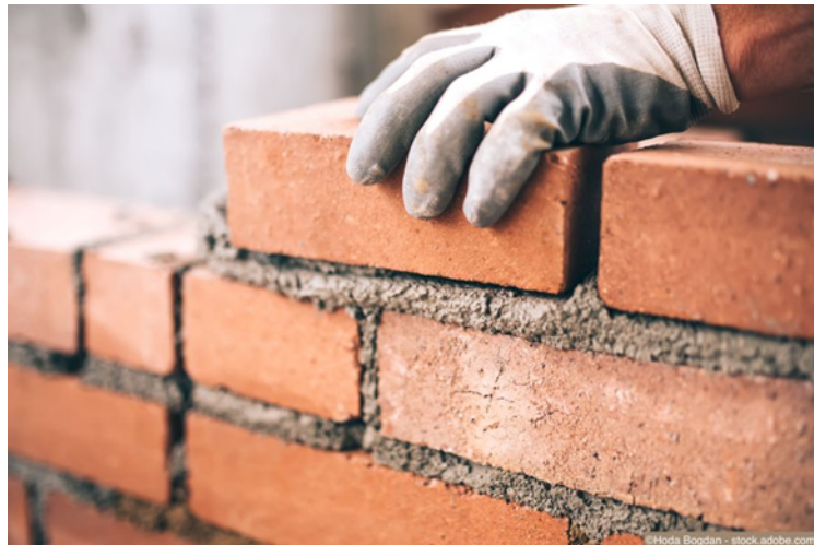
Figure. I.8: les joints de maçonnerie
