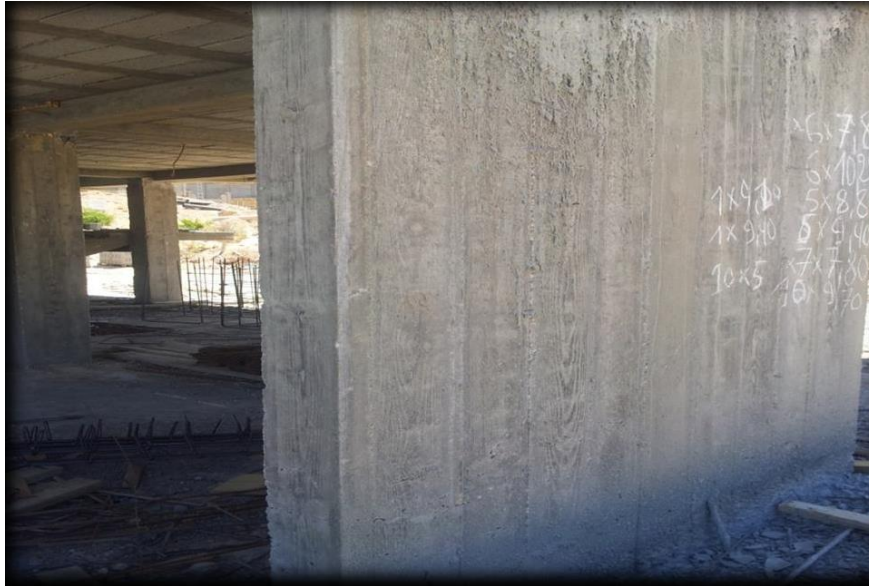
Figure II.3 : Voile en béton armé
