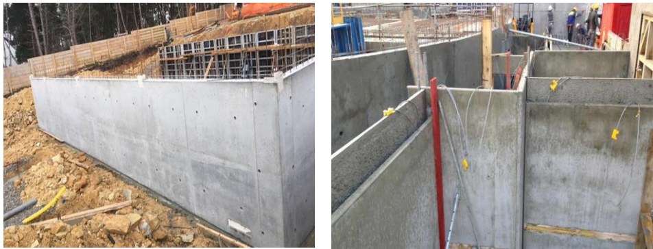
Figure II.1 : Construction en voile de béton armé
