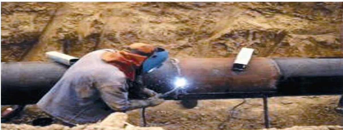
Figure IV.11 : Opération de soudages de demi coquilles (STT).
