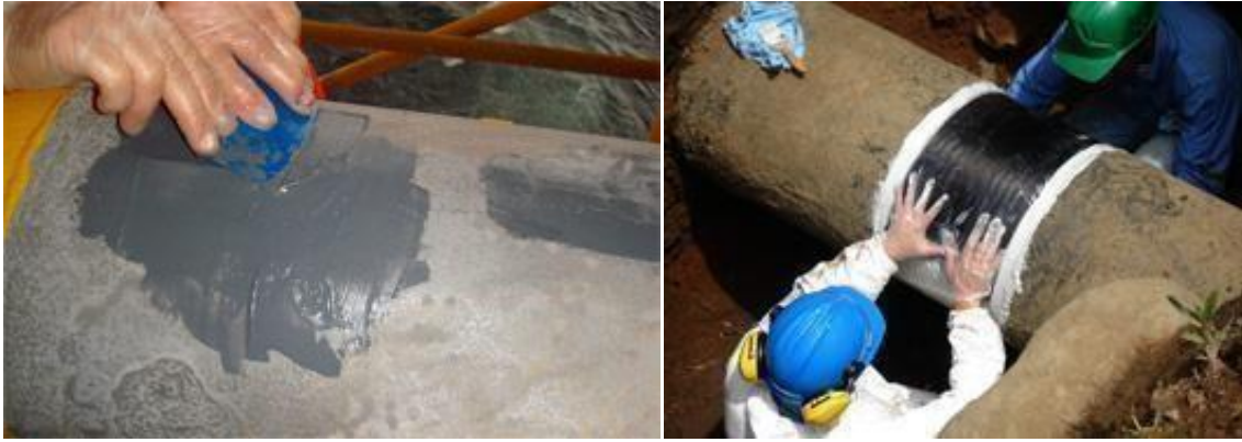
Figure IV.9. réparation d'un pipe par collage de patch a) collage par adhésif de film b)collage par adhésif de pâte
