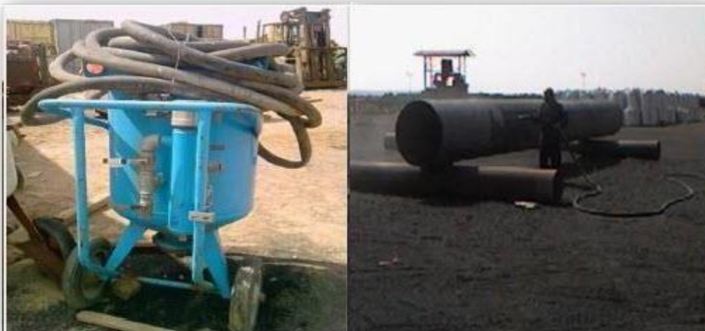
a) compresseur d'air projeter l'air comprimé avec des grains abrasif
