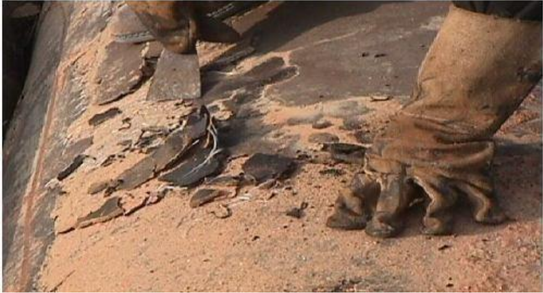
Figure IV.6. Décapage manuelle.
