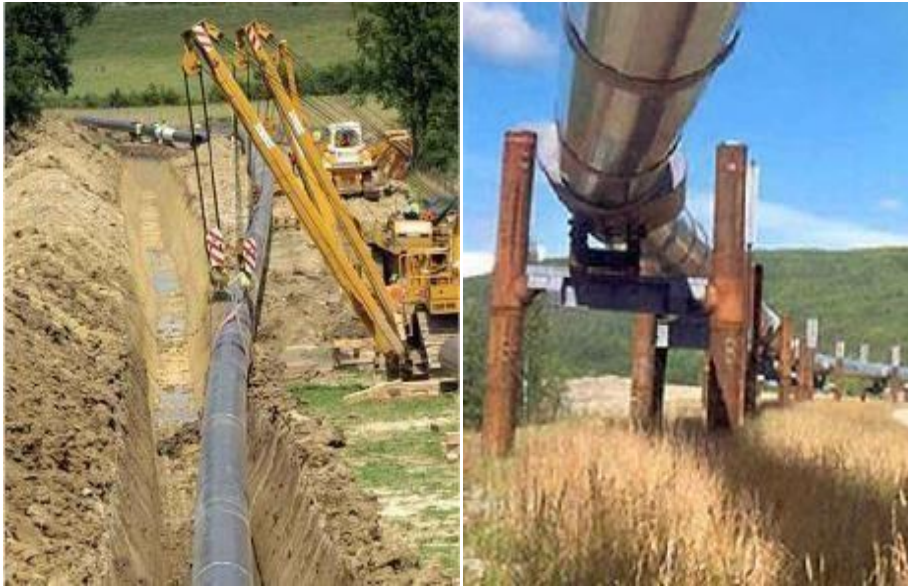
Figure I.1 : Canalisation enterrée [5] Figure I.2: Canalisation aérienne [6]
