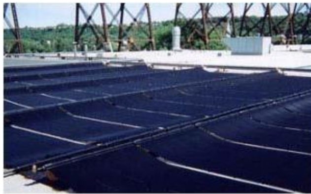
Figure I. 2 : Capteurs plans sans vitrage [8]
