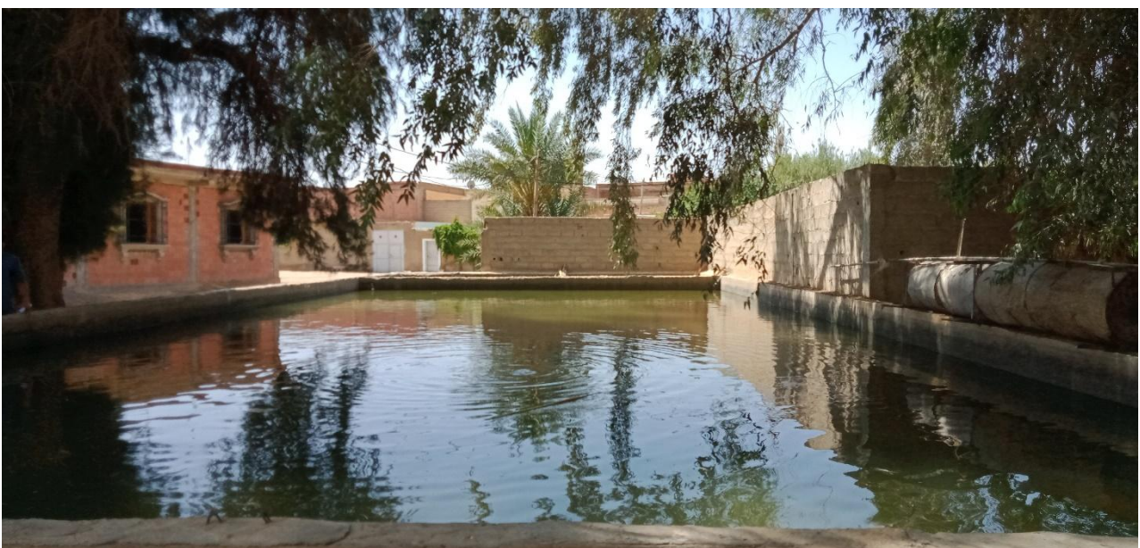
Photo 16 : Bassin bétonné de 3000 m 3 de l'exploitation aquacole de M'Cif
