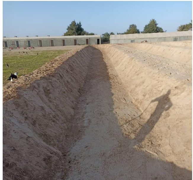
Bassins en géomembrane en voie de réalisation
