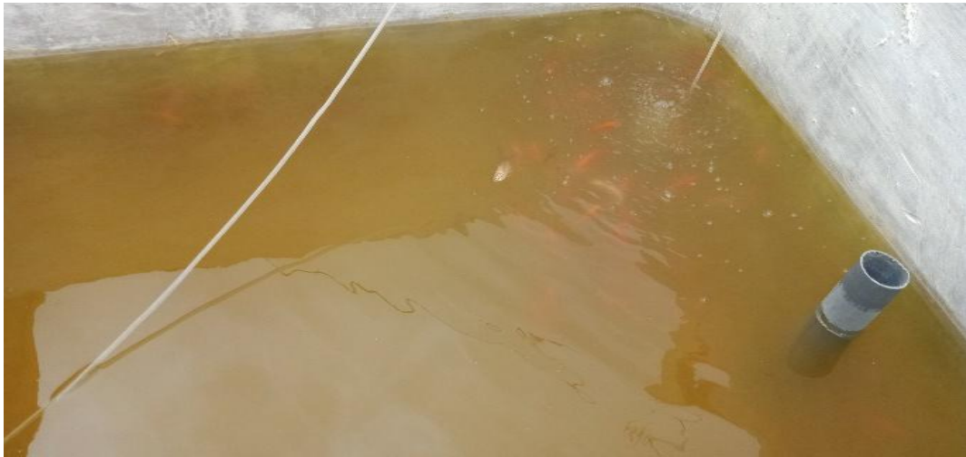
Bassin bétonné de 360 m 3
