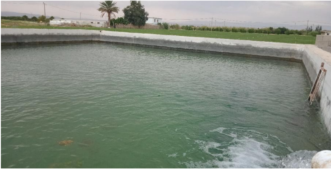
Photo 13 : Bassin bétonné de 3000 m 3 de l'exploitation aquacole de Khobana
