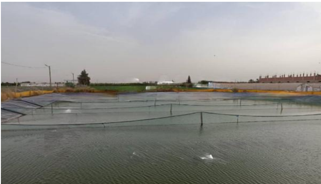
Photo 14 : Bassin en géomembrane de 3000 m 3 de l'exploitation aquacole de Khobana
