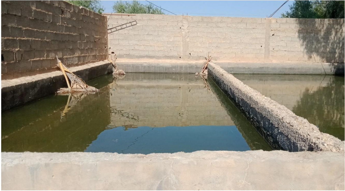
Bassin bétonné de 3000 m 3 de l'exploitation aquacole de M'Cif
