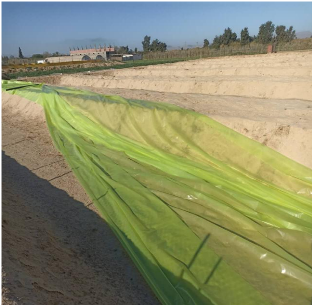
Bassins en géomembrane en voie de réalisation
