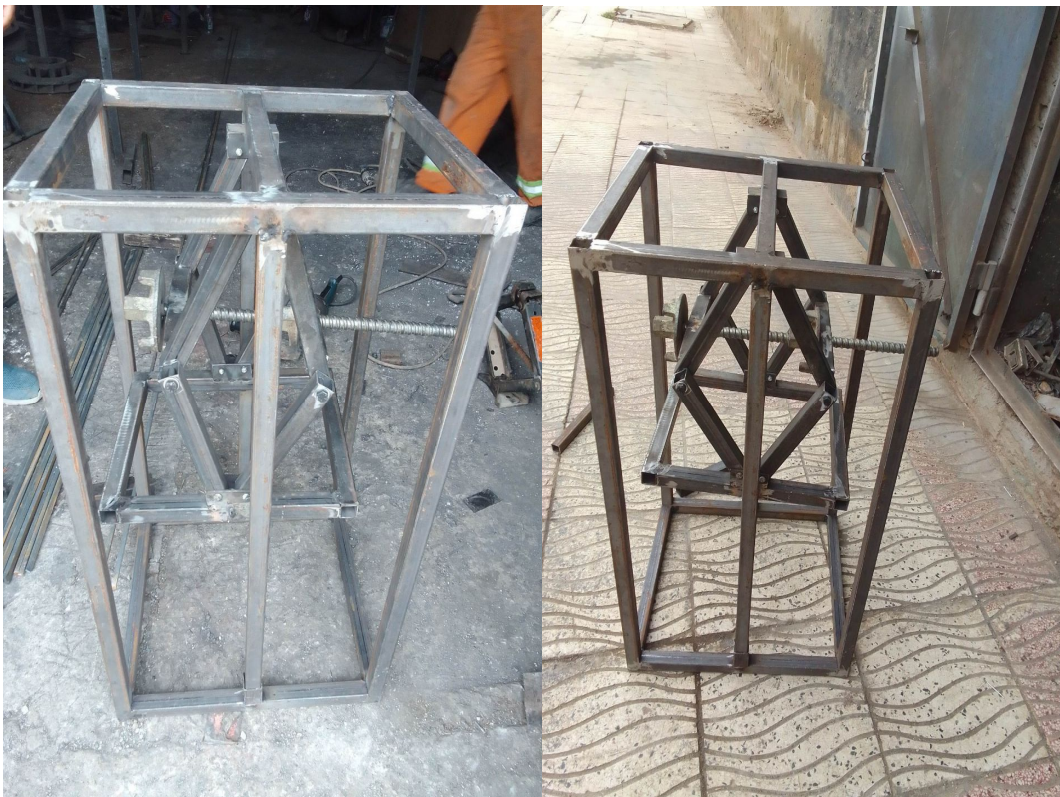
Figure 55 : Assemblage de l'armature support avec le système de compactage des déchets
