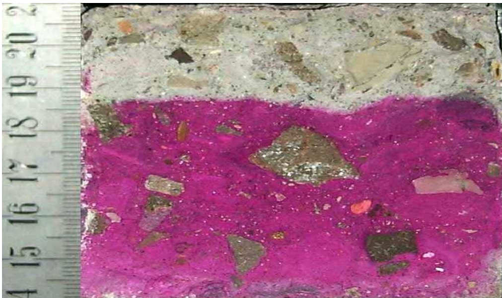
Figure I.11 : Evaluation de la profondeur carbonatée à l'aide d'un indicateur coloré (phénolphthaléine). La mesure est faite sur une fracture fraîche de béton (coloration rose : zone non carbonatée), (Baroghel-Bouny, Juillet 2004).
