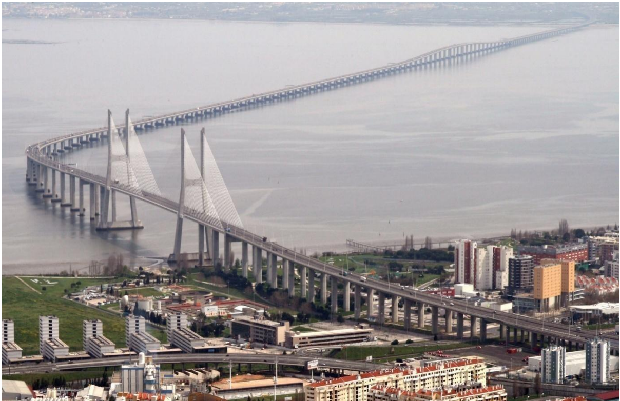
Figure 02 : Pont Vasco de gamma sur le Tage à Lisbonne au Portugal réalisé en 1998 pour une durée de vie de 120 ans ; (Indicateurs de durabilité : coefficient de diffusion par la méthode Tang Luping D_{app} = 12 \cdot 10^{-12} \text{ m}^2 \text{ s}^{-1} et Perméabilité à l'oxygène < 12 \cdot 10^{-17} \text{ m}^2 )
