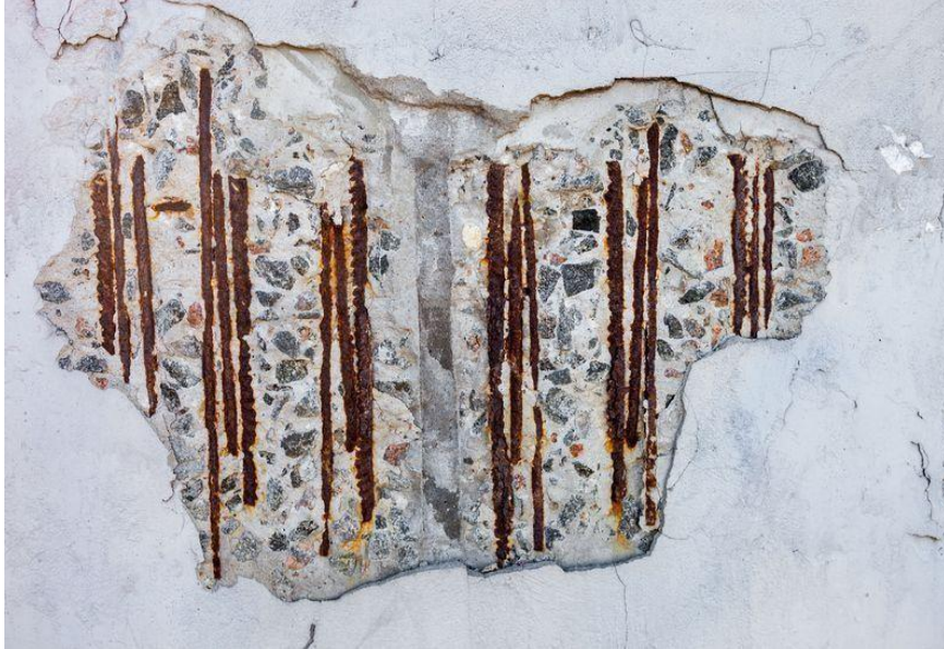
Figure I.8: Lessivage du béton ( http://www.guidebeton.com/ )
