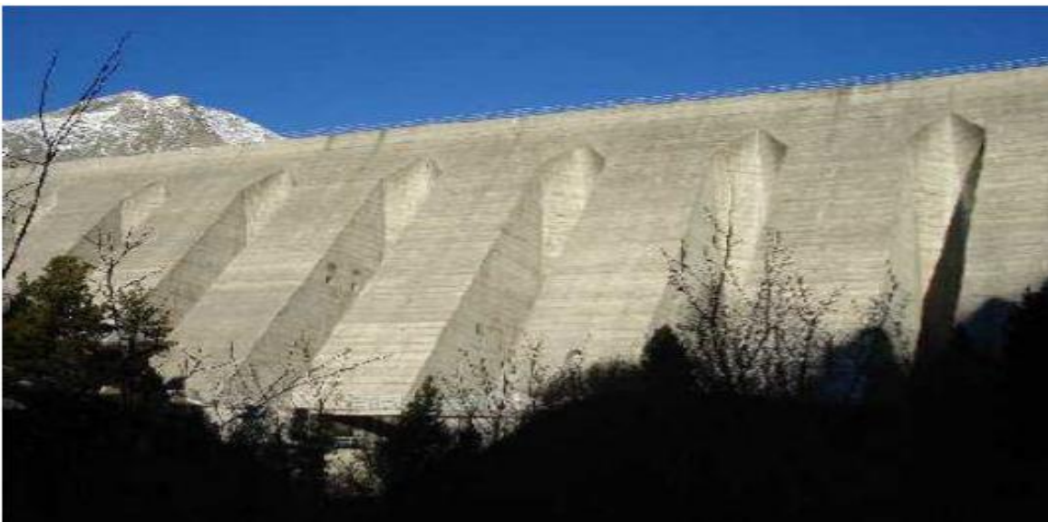
Figure I.5 : Barrage creux de Pesanteur
