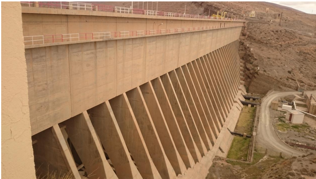
Figure III.5 : Photo des contreforts du barrage EL K'sob.
