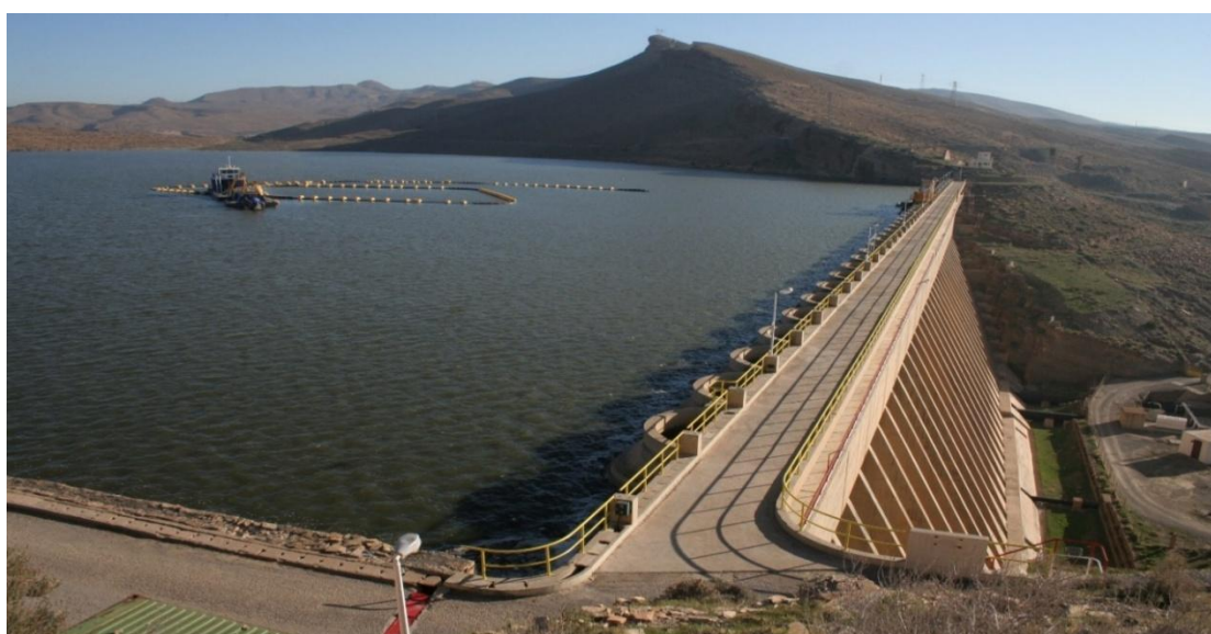
Figure III.3 : Photo de Vue du barrage.
