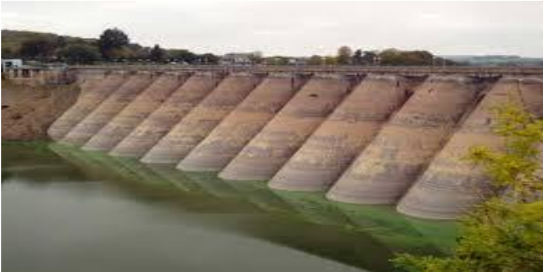
Figure I.4 : Barrage à multi voûtes
