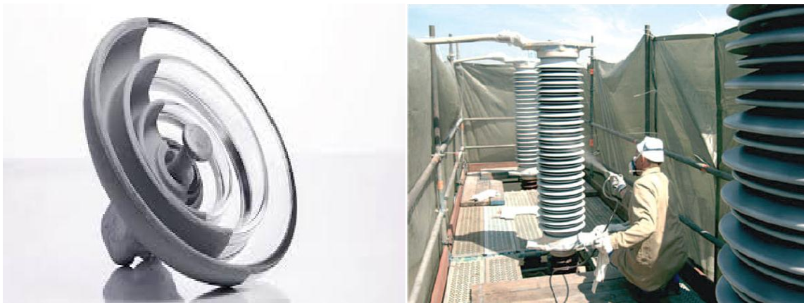
Figure I.7 Revêtement silicone d'isolateur
