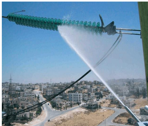
Figure I.8 Nettoyage des isolateurs
