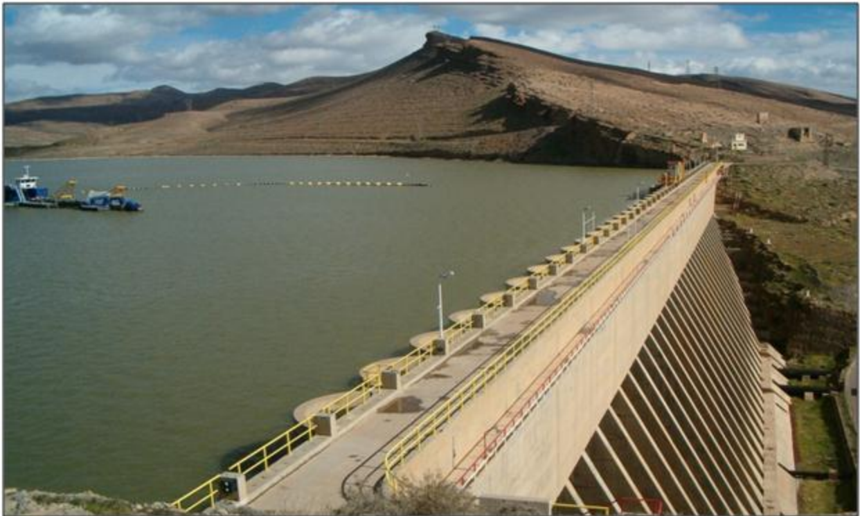
Figure III.5: Photo des contreforts du barrage EL K'sob.
