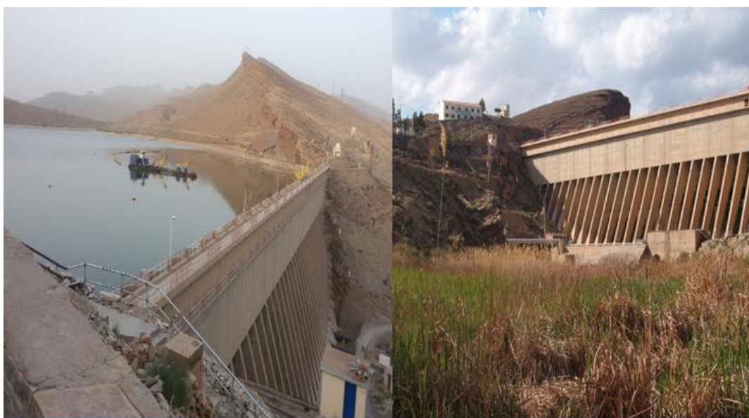
Figure III.3: Photo de Vue du barrage, face aval.
