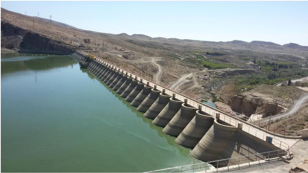
Figure III.6: Photo des voûtes en face amont du barrage K'sob.
