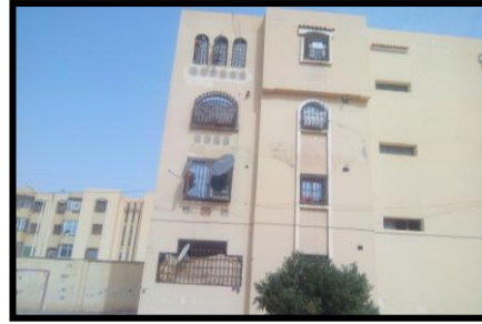
صورة رقم (14): المبنى في حالة متوسطة
