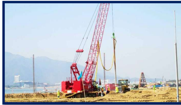
Figure 1.16 : réalisation de vibrocompactage (document de Menard Canada 2025).
