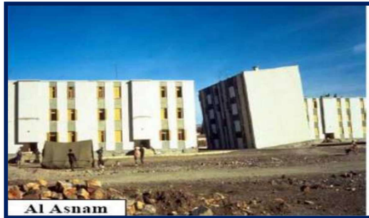
Figure 1.9 : phénomène de liquéfaction a Al Asnam 1980.
