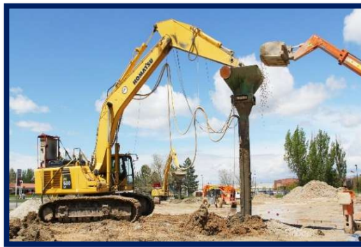
Figure 1.19: les colonnes ballastées.
