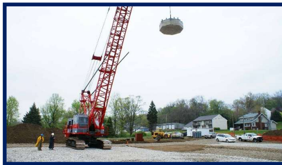
Figure 1.15 : réalisation de compactage dynamique (document de Ménard canada).
