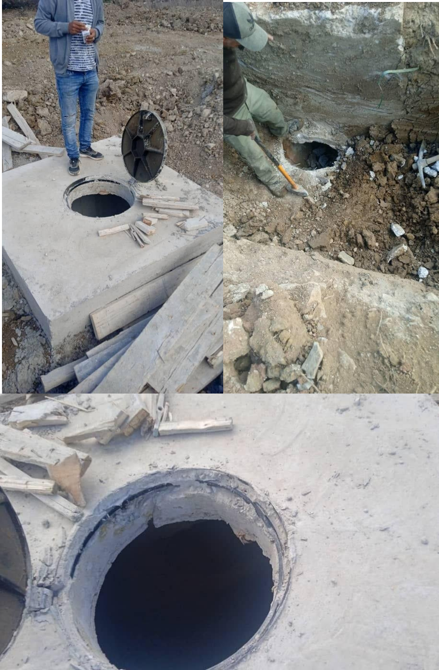
الملحق 10 صور توثيقية لمراحل تعديل مسار شبكة الصرف الصحي و تجهيز غرف التفتيش في موقع الورشة مقدم من طرف المقاول 2026.
