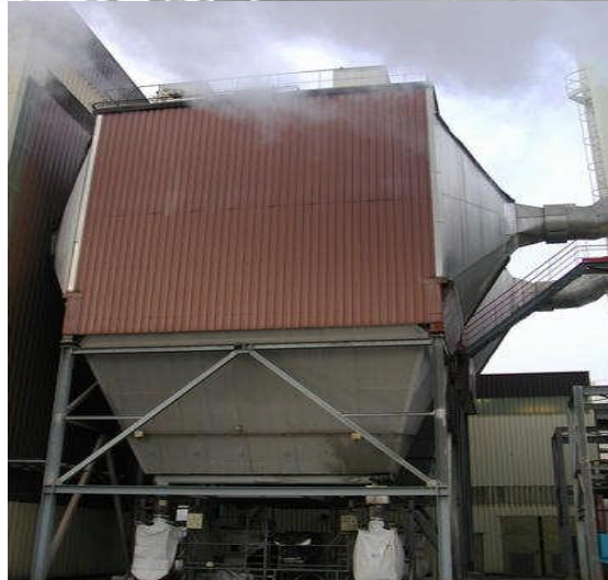
Figure I.11: l'électrofiltre sec
