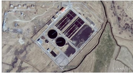
FIGURE 2.5 – : Vue générale de la STEP de M'sila (Google earth 2016)
