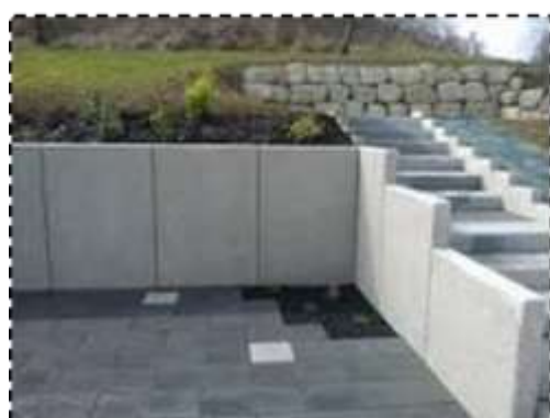
جدار إسناد ثقيل mur de soutènement lourd
